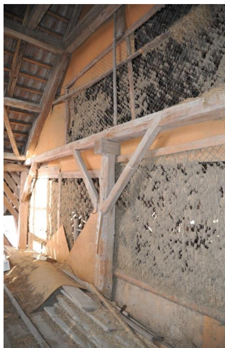
Abb. 43: Blick nach Süd-osten: Detail Q2 mit Vordachkonstruktion (Bild links).
