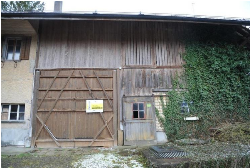
Abb. 49: Nördliche Trauffassade Ökonomieteil.
