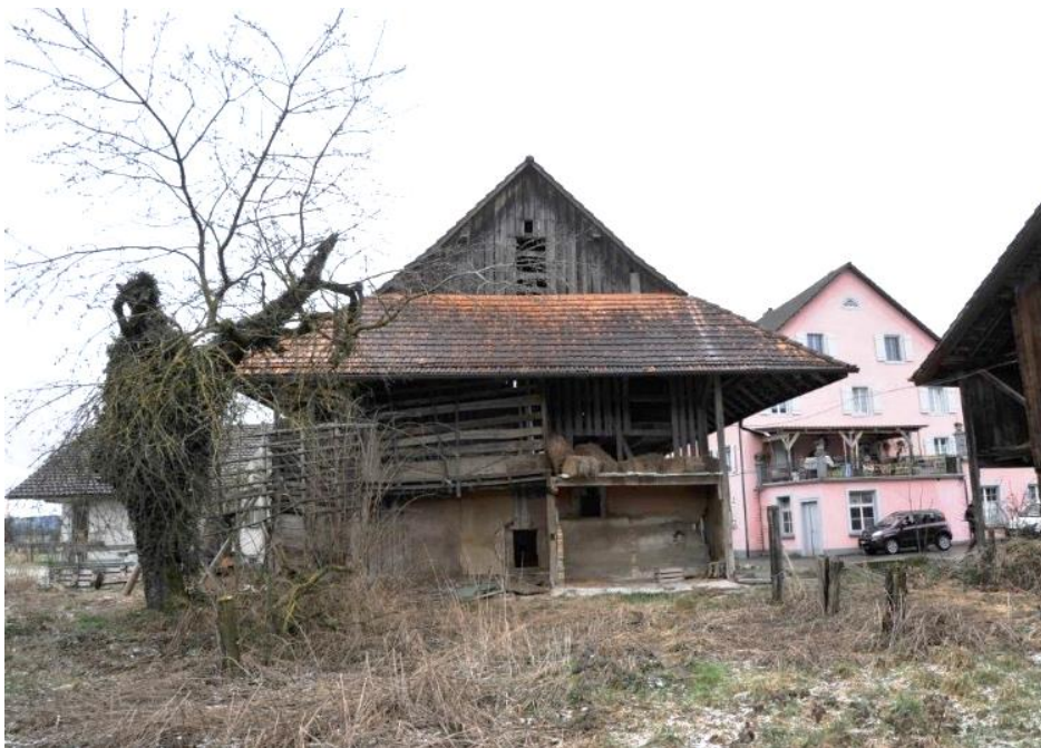
Abb. 61: Ostfassade Stallscheune Ausserdorfstr. 44.
