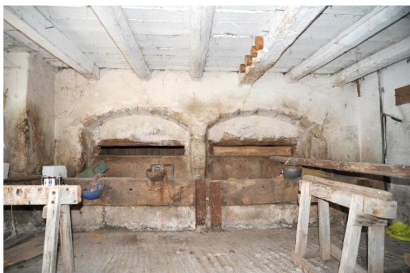
Abb. 38: Stall, Blick nach Westen an die Futterkrippen.
