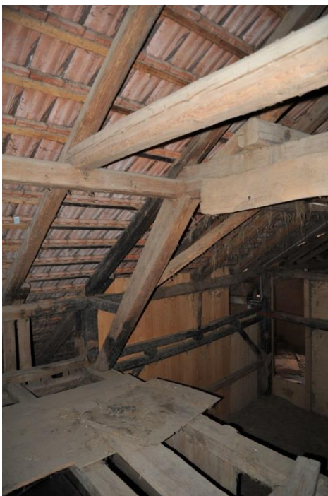
Abb. 35: Kniewand und Dachfusskonstruktion über dem Wohnteil (Bild oben).
