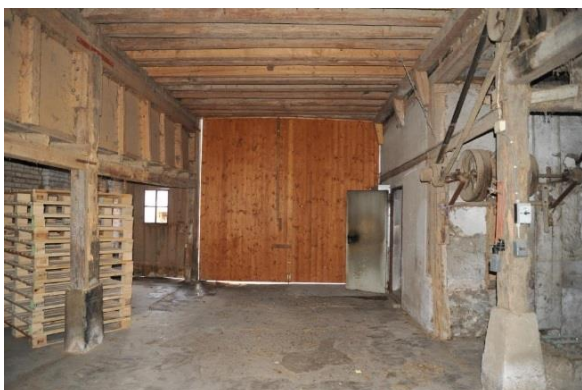
Abb. 26: Tenn, Blick nach Norden an das Tor. Links im Bild Querbund Q3; rechts Querbund Q4.
