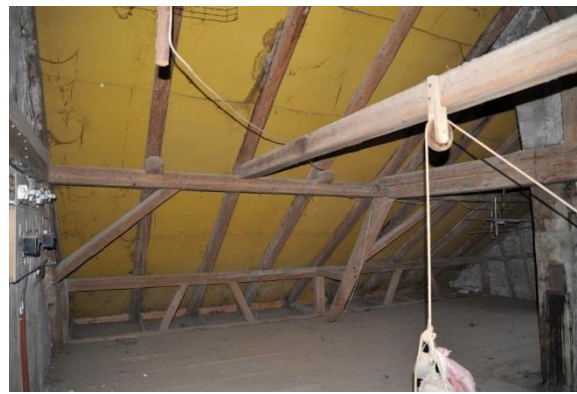
Abb. 111: DG, Blick nach Norden.
