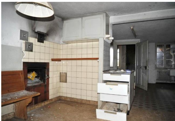
Abb. 73: Küche Nord 002, Blick nach Süden.
