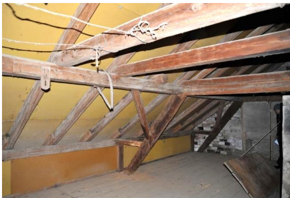
Abb. 110: DG, Blick nach Südwesten.
