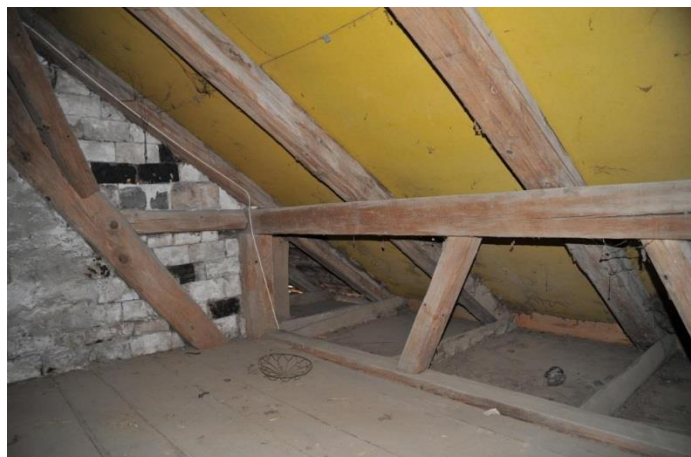
Abb. 35: Kniewand und Dachfusskonstruktion über dem Wohnteil (Bild oben).
