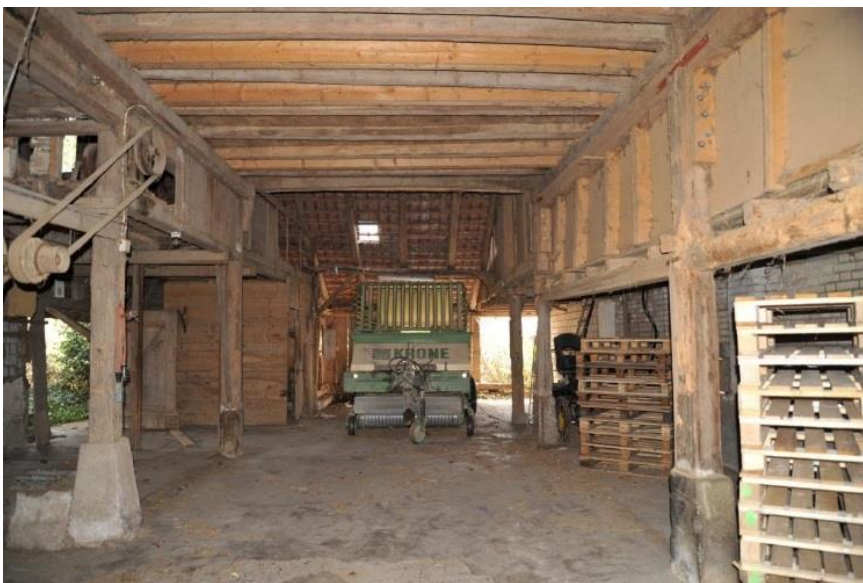
Abb. 25: Tenn (zwischen Q3 und Q4), Blick nach Süden an die Erweiterung unter abgeschlepptem Dach.
