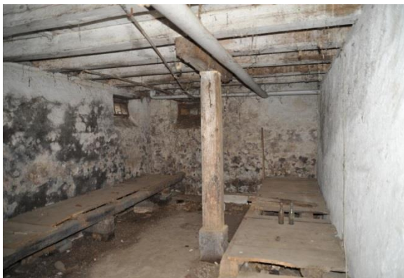
Abb. 65: Nördliche Kellerhälfte, Blick nach Osten.
