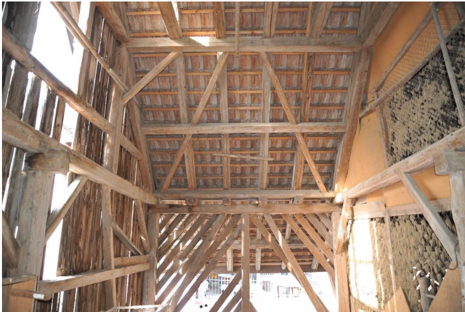
Abb. 42: Dachwerk, Blick nach Norden an die beiden Querbünde Q1 und Q2, die das Tenn begrenzen.
