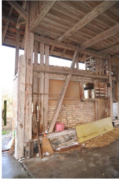
Abb. 59: Nordfassade, Blick nach Westen an die Vordachkonstruktion (linkes Bild).
