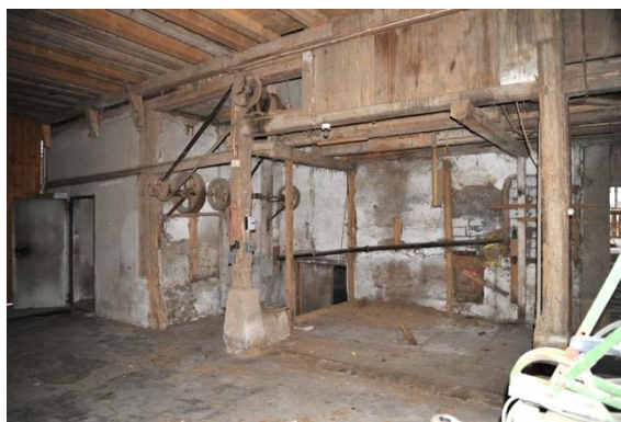
Abb. 27: Tenn, Blick Richtung Nordosten an den Querbund Q4 und dahinter die Scheidewand zum Wohnteil; links im Bild der jüngere Bad-Einbau.
