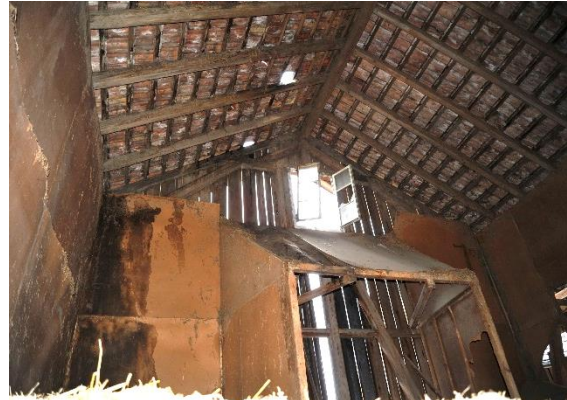
Abb. 33: Quergiebel, Blick nach Süden an die Giebelwand.
