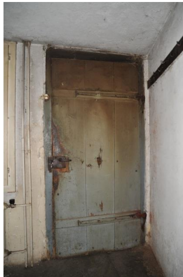
Abb. 84: Flur 006, Blick nach Süden an die Haustür.
