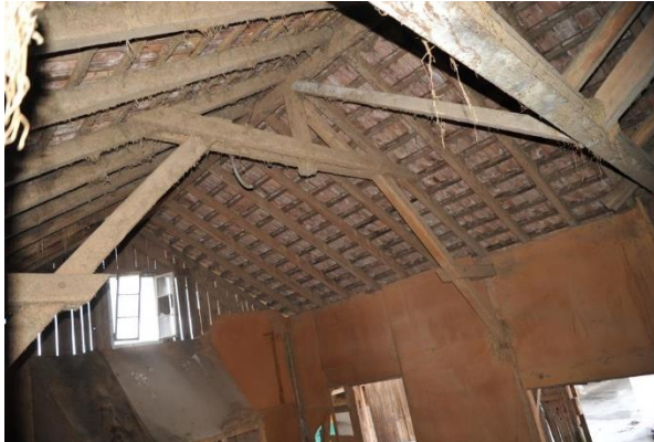
Abb. 32: Quergiebel, Blick nach Südwesten an das Dachwerk. Im Vordergrund das südliche Wandrähm des Vielzweckbauernhauses; dahinter der Binnenquerbund.
