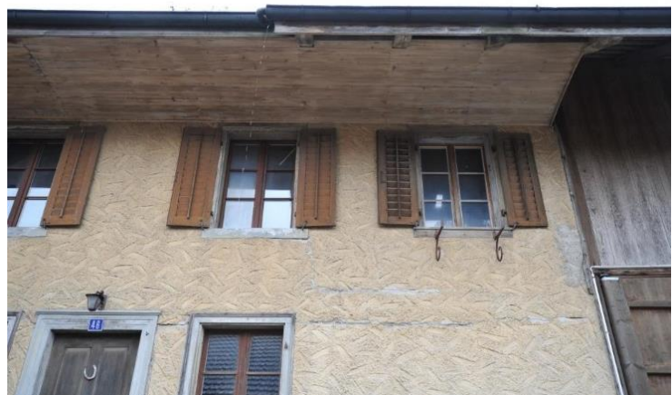
Abb. 47: Detailansicht der nördlichen Trauffassade mit Dachuntersichten. Rechts im Bild die nachträglich zu Wohnzwecken ausgebaute «Zwischenzone» (oben).
