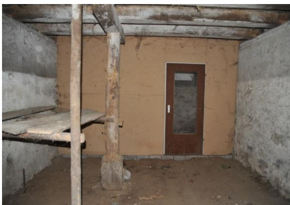
Abb. 67: Südliche Kellerhälfte, Blick nach Osten.
