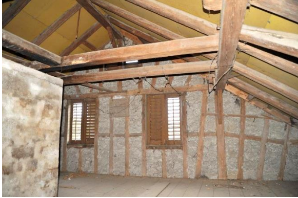
Abb. 108: DG, Blick nach Nordosten an die Giebelwand.
