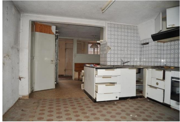
Abb. 82: Küche Süd 005, Blick nach Norden.
