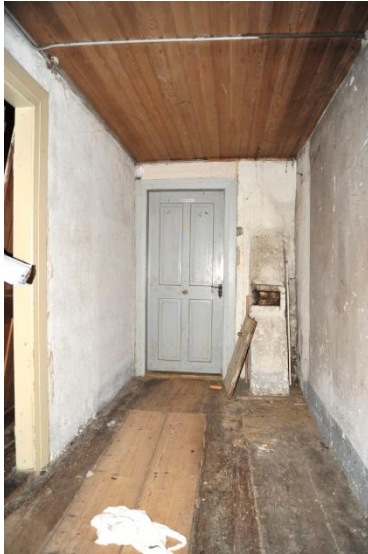
Abb. 87: Flur 101, Blick nach Osten.
