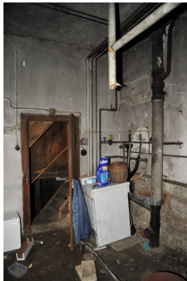
Abb. 21: Querzone zwischen Q4 und Q5: EG, Blick nach Nordwesten (Bild links).
