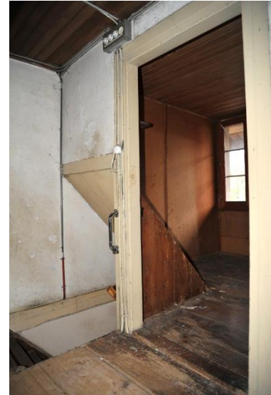
Abb. 89: Flur 101, Blick nach Nordwesten an den Treppenaufgang.
