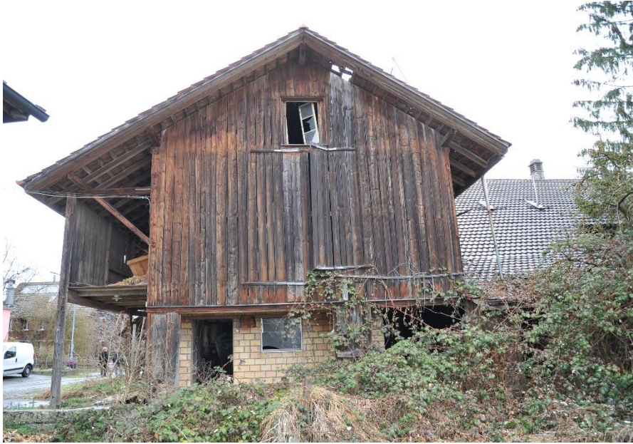
Abb. 55: Südfassade Ökonomie mit Quergiebelanbau.
