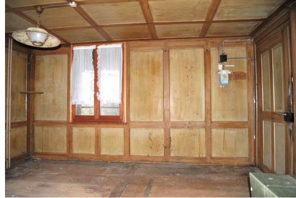
Abb. 78: Stube Süd 004, Blick nach Süden.
