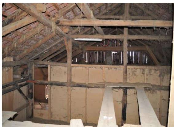
Abb. 29: Blick nach Westen an den Querbund Q3 mit stehendem Dachstuhl.
