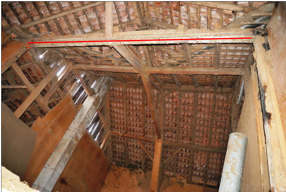
Abb. 34: Dachwerk, Blick an die beiden westlichen Querzonen. Im Vordergrund (rot markiert) das südliche Wandrähm des Vieltzweckbauernhauses.
