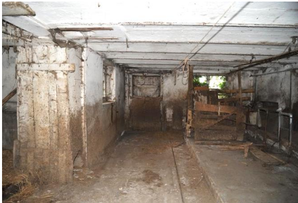
Abb. 30: Nördlicher (älterer) Stallbereich mit Hourdis-Decke, Blick nach Norden.
