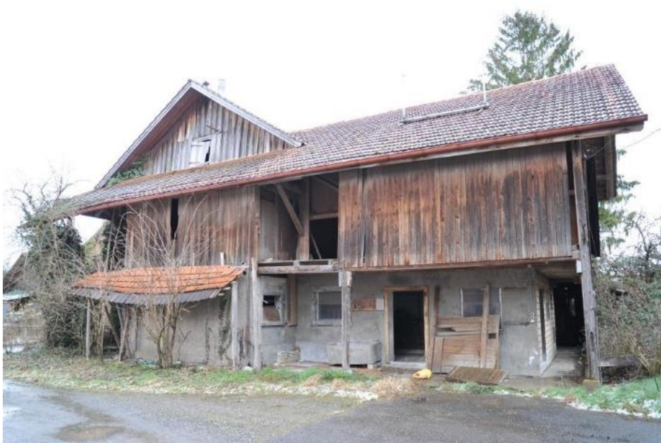
Abb. 56: Westliche Giebelfassade des Ökonomieteils mit Erweiterung unter Quergiebel nach Süden.
