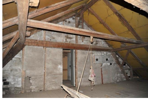
Abb. 109: DG, Blick nach Nordwesten an Querbund Q5, nachträglich zugemauert.
