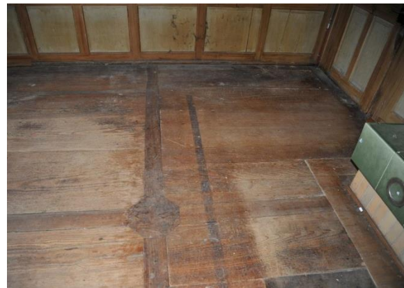
Abb. 80: Stube Süd 004, Blick nach Süden. Detail Bretterboden mit dunklem Fries.
