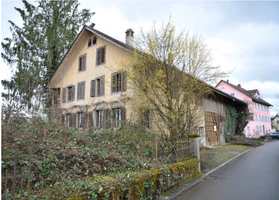
Abb. 50: Östliche Giebel- fassade Wohnteil.
