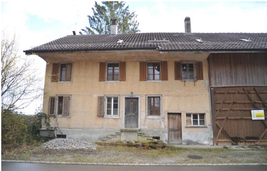
Abb. 46: Nördliche Trauffassade, Wohnteil.
