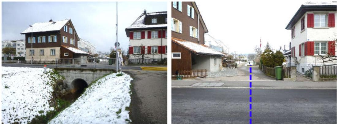
Abbildung 32: Fr\_02 Durchlass unter der Stallikerstrasse (links) mit verlängerter Eindolung unter der Stallikerstrasse (rechts). Blick in Fliessrichtung.
