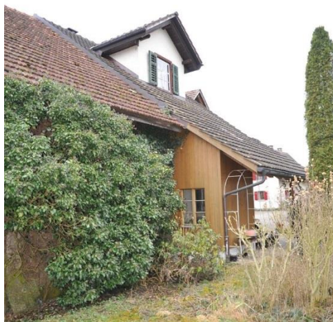
Abb. 33: Nördliche Trauffassade Wohnteil mit rückseitiger Erweiterung.
