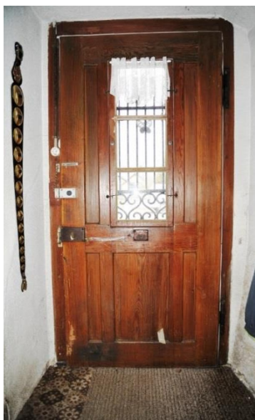
Abb. 41: 001, Blick nach Westen an die Haustür.
