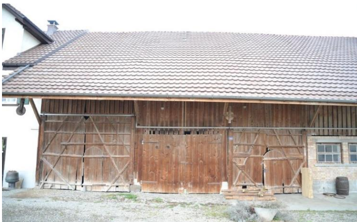
Abb. 28: Detailansicht der südlichen Trauffassade mit Tennzonen und mittlerer Remise.
