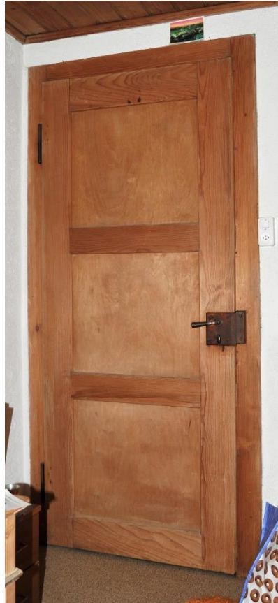
Abb. 38 (links): Ansicht einer Dreifüllungstür mit oberer Verglasung (Raum 102).
