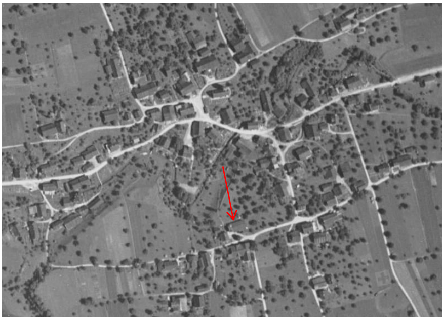
Abb. 6: Flugaufnahme von Maschwanden 1931, https://api3.geo.admin.ch/luftbilder , Signatur: 19310530021274. Das Gebäude Ausserdorfstr. 25/27 ist mit einem roten Pfeil markiert. Der Quergiebel scheint zu diesem Zeitpunkt schon zu bestehen.
