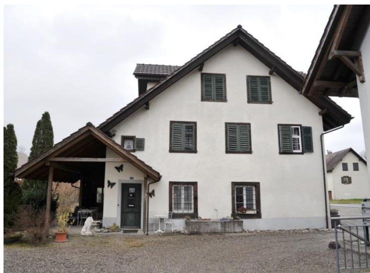
Abb. 35: Westliche Giebelfassade Wohnhaus.
