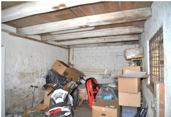
Abb. 23: Östlicher Anbau, Blick nach Norden.
