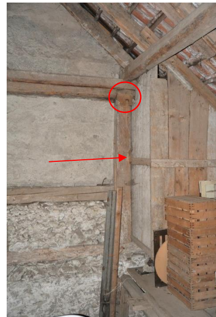
Abb. 18 (rechts) Ständer eines älteren Holzgerüsts mit leerer Blattsasse (roter Pfeil). Das darauf liegende Rähm ist abgesägt (rot eingekreist); die jüngere Konstruktion baut auf dem Bunddachbalken auf.
