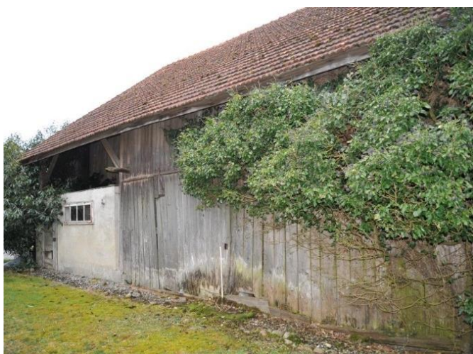
Abb. 32: Nördliche Trauffassade Ökonomieteil.
