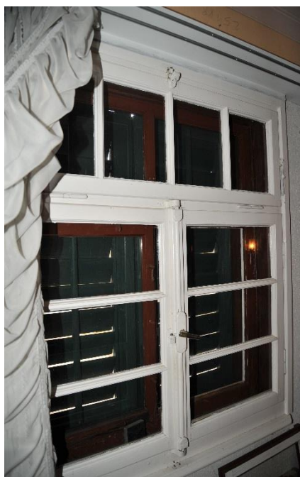
Abb. 36: Ansicht eines Fensters aus den 1930er Jahren (Raum 103).
