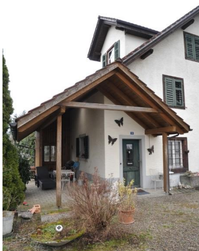
Abb. 34: Westliche Giebelfassade; Abschleppung und geschützter Eingangsbereich.
