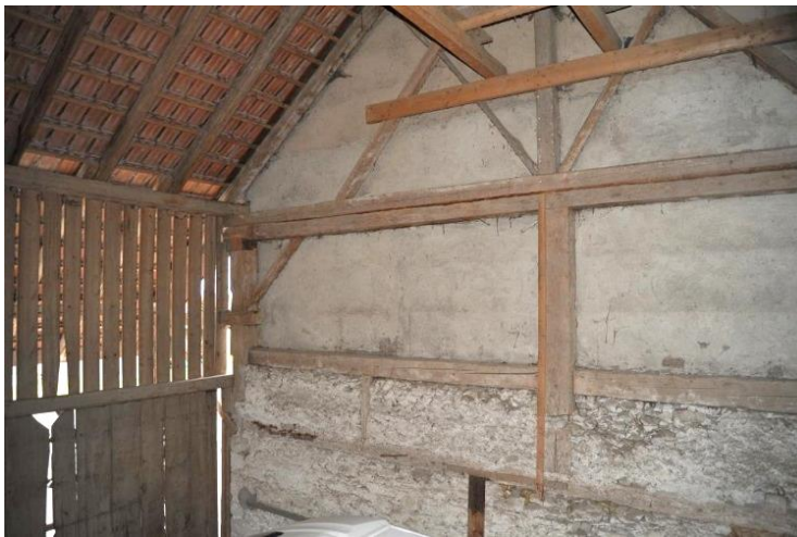
Abb. 17 (oben) Scheidewand zum Wohnteil, Blick nach Südwesten.
